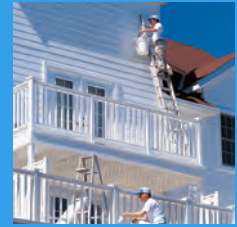
Paint Installation รับเหมาทาสี
