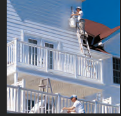
Paint Installation รับเหมากาหาลี
